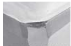
Concorrente C Dopo la lavorazione 11 m
